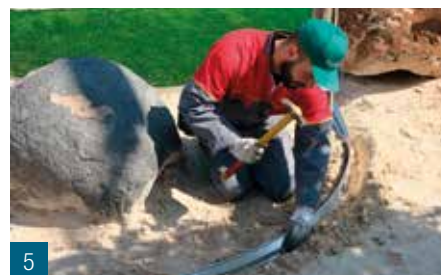
5 Ancoraggio al terreno con picchetti o altri metodi. Anchoring to the ground with pickets or other methods. Bodenverankerung mit Nägeln oder ähnlichen. Ancre au sol avec des piquets de grève ou d'autres méthodes.
