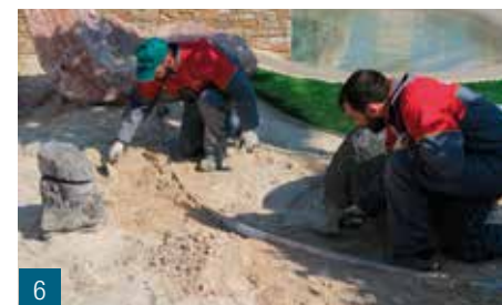
6 Compattazione del terreno intorno alla bordura. Compacting the soil around the edging. Verdichtung des Bodens am Rand. Compaction du sol autour de la bordure.
