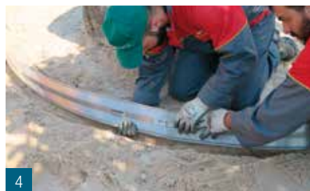
4 Curvatura e accoppiamento con incastro. Curving and coupling with interlocking. Biegen und Formen mit Gelenk. Courbure et couplage par emboîtement.
